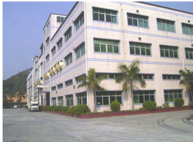
東莞WST生產大樓 WST production building
